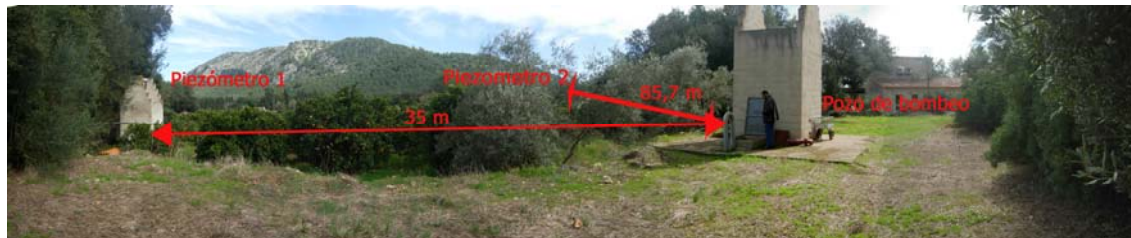
Panorámica del pozo de bombeo y piezómetros de observación
