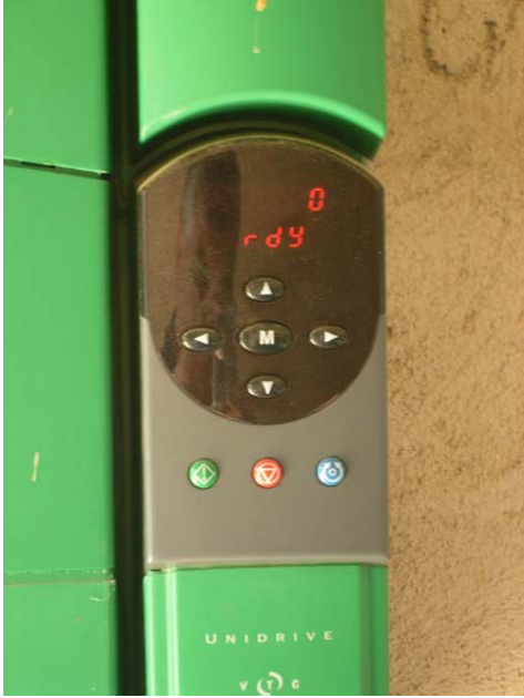
Regulador de frecuencia de electrobomba VTC
